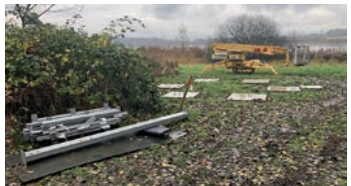
Neue Fundamente für den 2. Beobachtungsturm (Stand 4.12.2019)
